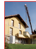
Sciage de béton armé, pierre naturelle
